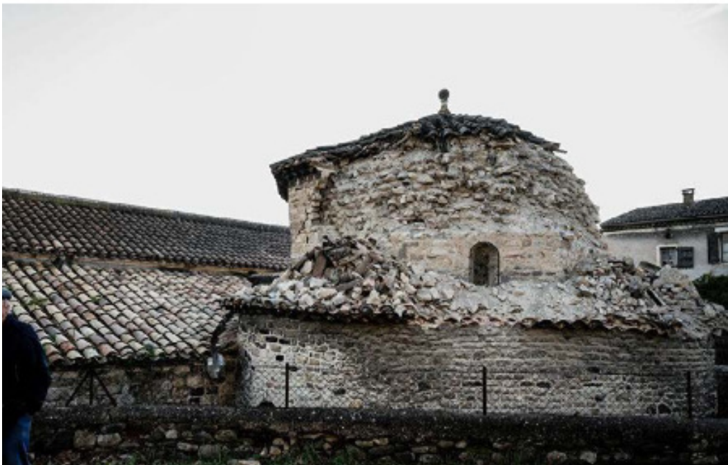
Dégâts du séisme du 11 Novembre 2019 (Magnitude 4,8-4,9 et Intensité locale VII-VIII) au Teil (Ardèche) sur le toit d'un baptistère.
