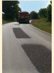
Les réparations ne sont effectuées que sur les surfaces ponctuelles à traiter où les voiries ont subi des dégradations de surface : nids de poule, arrachements, faïençages... La technique du « point-à-temps » est indispensable pour maintenir en état les chaussées et éviter qu'elles ne se dégradent trop rapidement (surtout après les périodes de gel et dégel en hiver), engendrant de facto des coûts de réparation plus élevés.
