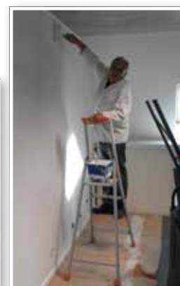
M. Josse, adjoint en charge des travaux et des bâtiments, a fait vis ma vie de peintre aux services techniques
