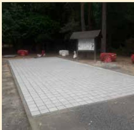
Ainsi, les places de stationnement sont refaites en pavés, afin de garder le sol perméable et l'allée principale du parking est réalisée en enrobé poncé.
